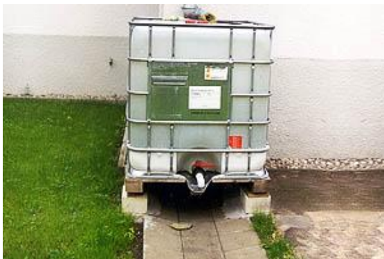
(1) Zur Gartenbewässerung kann das Regenwasser einfach in oberirdischen Zisternen aufgefangen werden http://emscher-regen.de/
